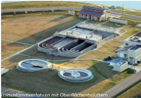
Aktivschlammverfahren mit Oberflächenbelüftern
